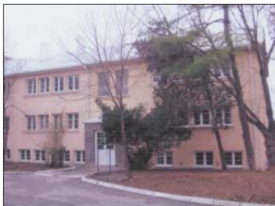
Zrekonstruovaný pavilon urologie nemocnice v Bělehradě
